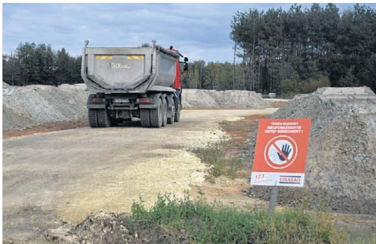
Kontrola nie powoduje konieczności wstrzymania prac przy obwodnicy
