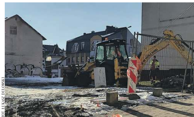
(ŁD) Budowa Skweru Róży przy Dobczyckiej w Chrzanowie
