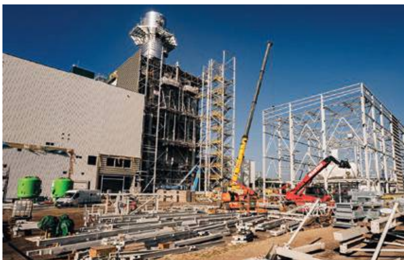
Budowany blok parowo-gazowy PGE Nowy Rybnik
