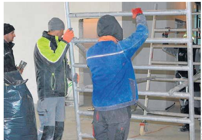
Trwa rozbudowa szkoły w Czarnej Dąbrówce. Inwestycję wykonuje miejscowa firma z Mikorowa. Koniec prac jeszcze w tym roku
