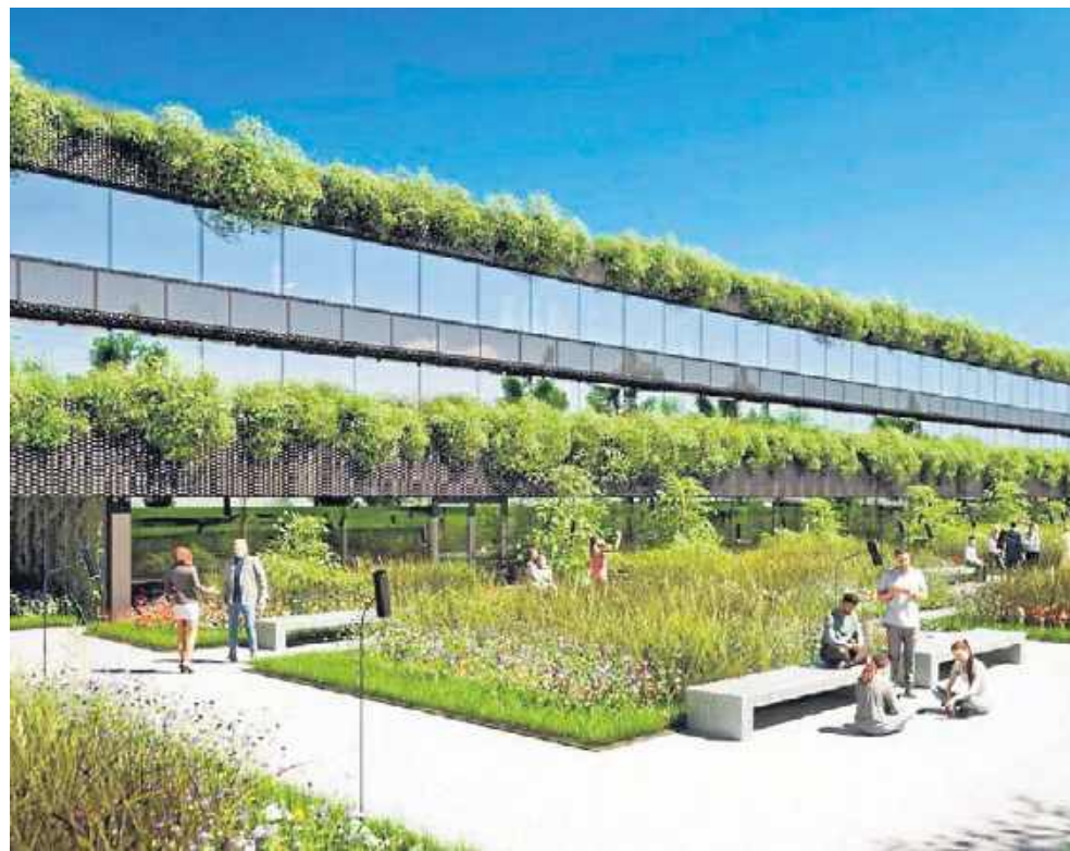
Tak ma wyglądać ostatnia niezagospodarowana część budowy wstrzymanej 25 lat temu
