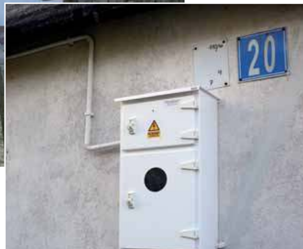
Na ścianie domu wreszcie pojawiła się skrzynka energetyczna
