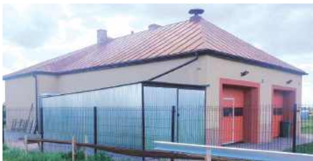
Dotychczasowe miejsce do przechowywania wyposażenia przestało już wystarczać, dlatego budowa dodatkowego garażu stała się koniecznością
