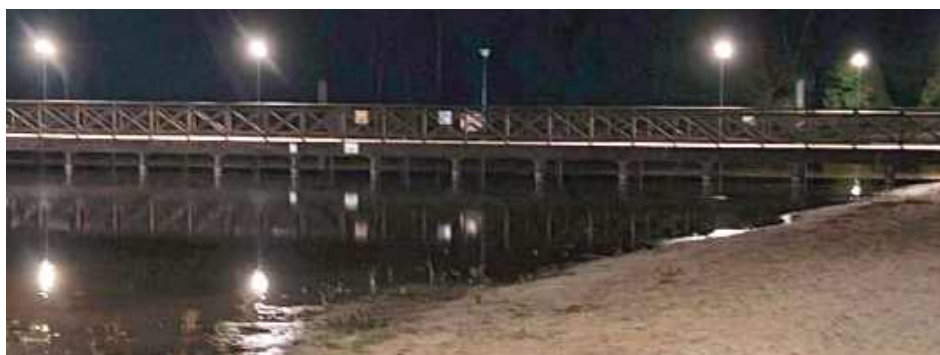
Internauta podsunął pomysł, żeby zrobić oświetlenie całej ścieżki wokół zalewu Zimna Woda w Łukowie
