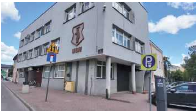
Ten budynek, dawna siedziba Szkoły Muzycznej w Łukowie, ma zostać wyremontowany
