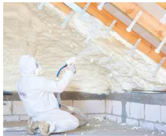
📍 Dach zaizolowany od wewnątrz pianką PUR. PCC PRODEX
