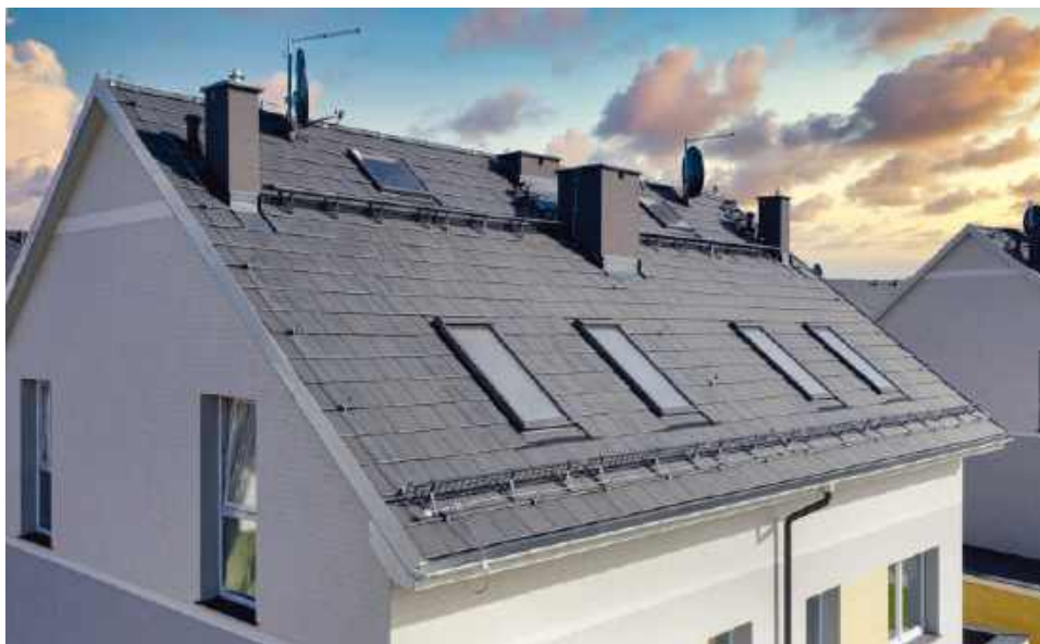
📌 Dachówki cementowe są większe od ceramicznych, a jednocześnie nieco lżejsze – 1 m 2 pokrycia waży około 45 kg. swissporton
