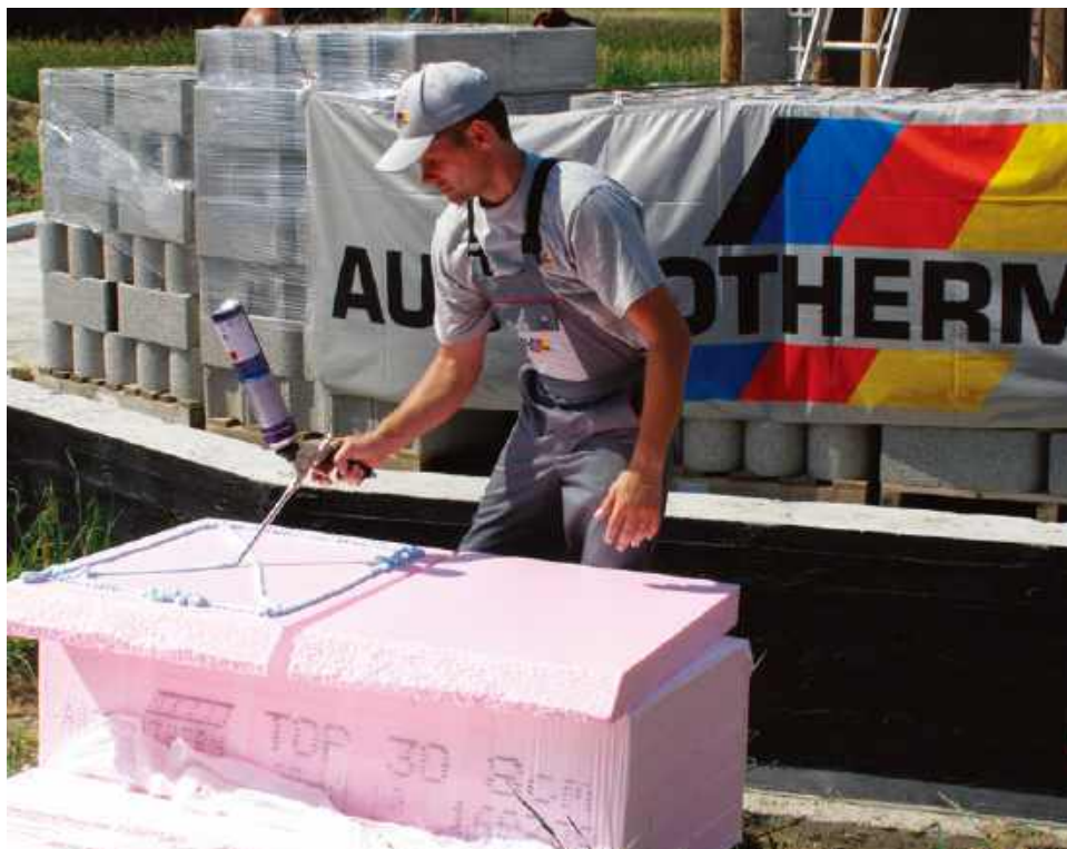
📍 Płyty XPS, wykorzystywane do izolacji termicznej fundamentów, są odporne na działanie wody. Dzięki temu stanowią dodatkową barierę przeciwwilgociową. AUSTROTHERM
