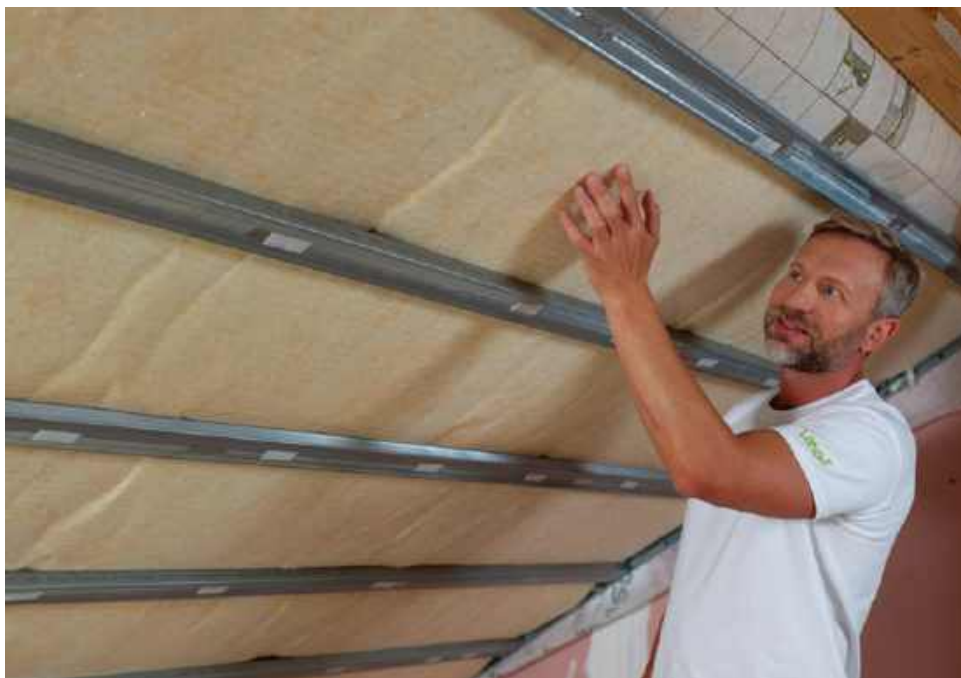
📍 Dachy skośne przeważnie ociepla się od wewnątrz, umieszczając wełnę między krokiewiami i pod nimi. ISOVER
