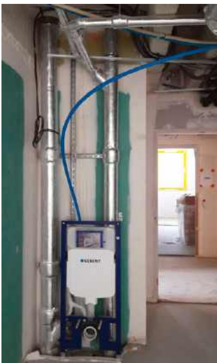
🔧 Rury kanalizacyjne mają dość dużą średnicę, dlatego ich ukrycie jest dużym wyzwaniem. ARMACELL
