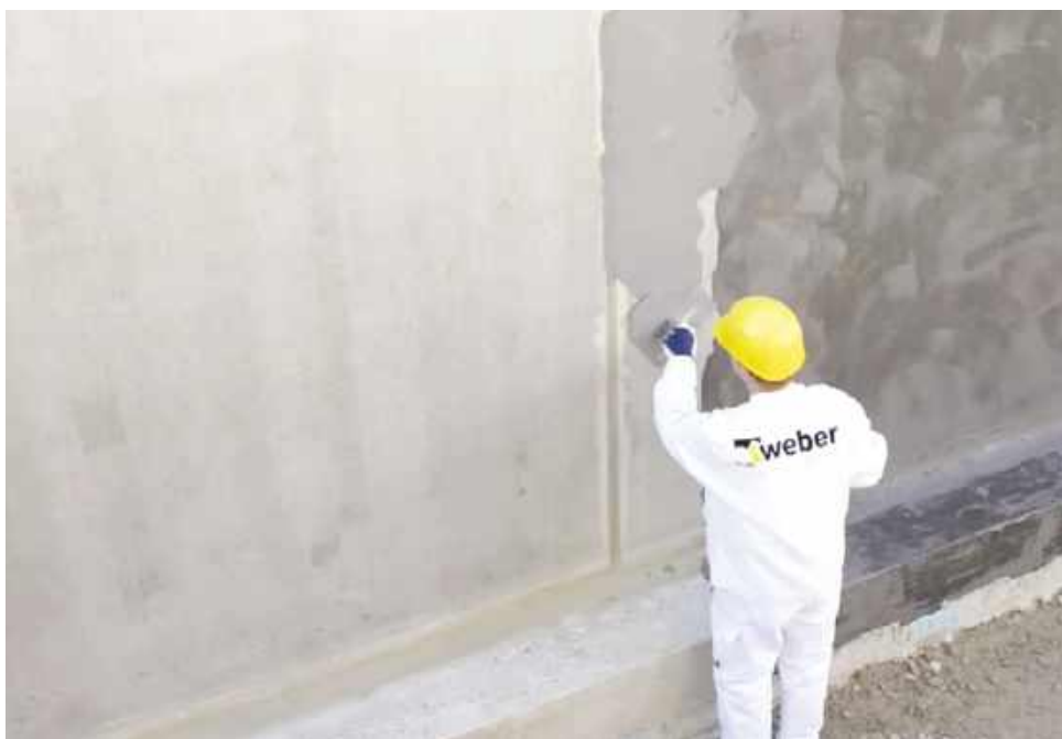
📍 Do uszczelniania fundamentów często stosuje się hydroizolacje mineralne (tzw. szlasy mineralne), bazujące na spoiwie cementowym. Po nałożeniu tworzą one bezspoinową powłokę hydroizolacyjną. Ze względu na właściwości, dzielimy je na sztywne i elastyczne.
