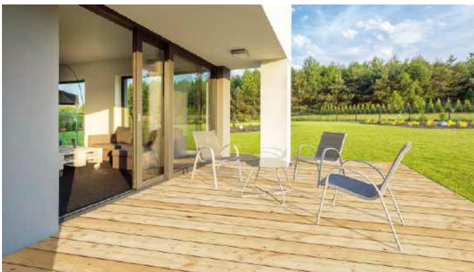
📌 Taras wykończony deskami z drewna modrzewia europejskiego o wymiarach 25 x 14,5 x 240 cm z wąskim ryflem. DLH
