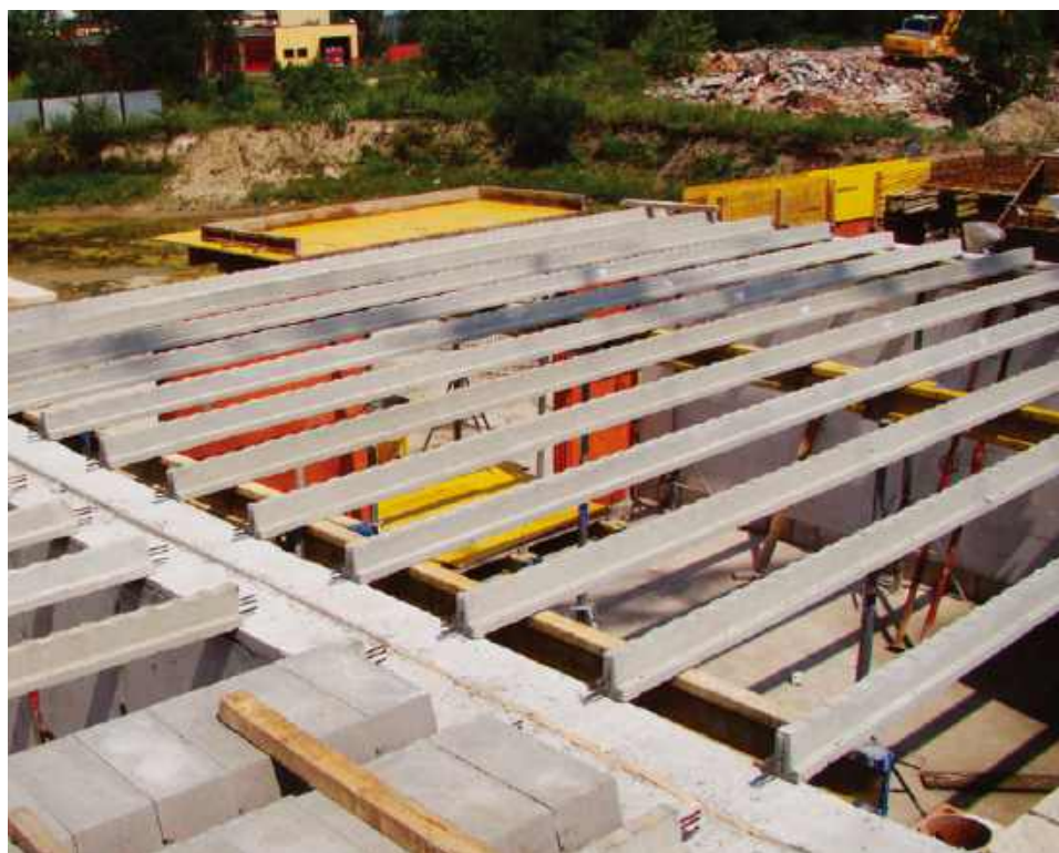
📍 Im większa jest odległość pomiędzy podporami, tym wykonanie stropu jest trudniejsze i droższe. RECTOR
