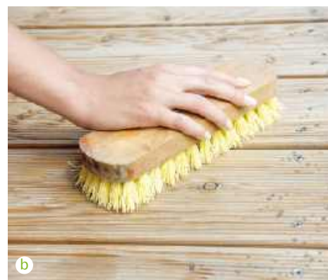
📌 Do mycia całego tarasu najlepiej użyć myjki ciśnieniowej (a KÄRCHER). Miejscowe zabrudzenia w postaci plam można usunąć szczotką ręczną (b JAF POLSKA).
