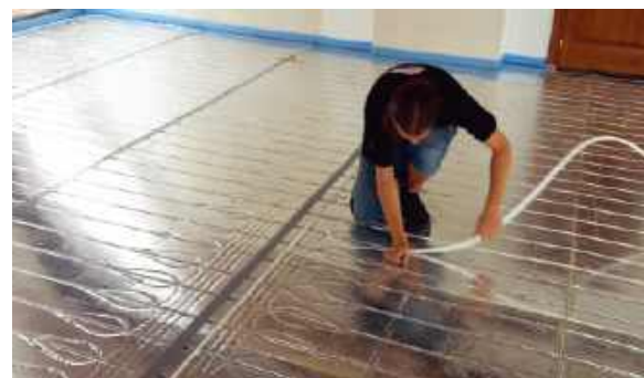
Isolacyjne płyty z wyfrezowanymi fabrycznie rowkami na rury ułatwiają wykonanie wodnego ogrzewania podłogowego w istniejących budynku. RWC
