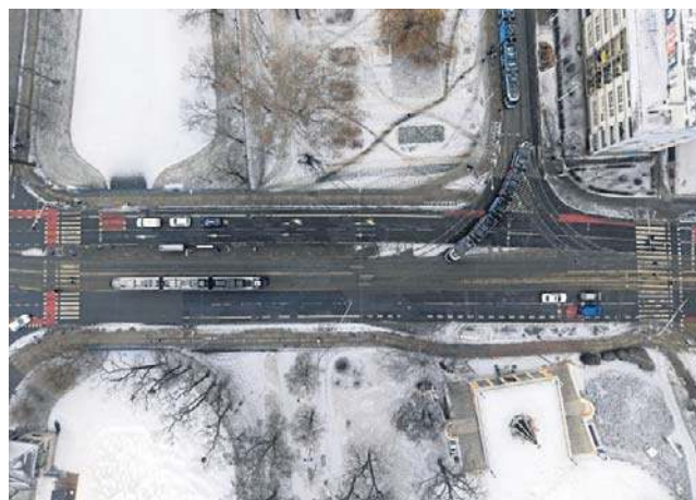
Wyremontowany zostanie odcinek jezdni prowadzący w stronę Galerii Dominikańskiej. Na zdjęciu na dole
