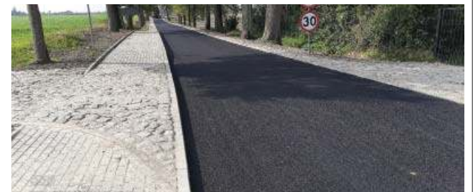
Teraz trwa remont niewielkiego odcinka drogi z Marwicy do Topolna Wielkiego
