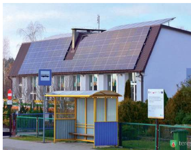
Instalację z magazynem energii widać z daleka na budynku Zespołu Szkół w Terespolu-Zaorendzie
