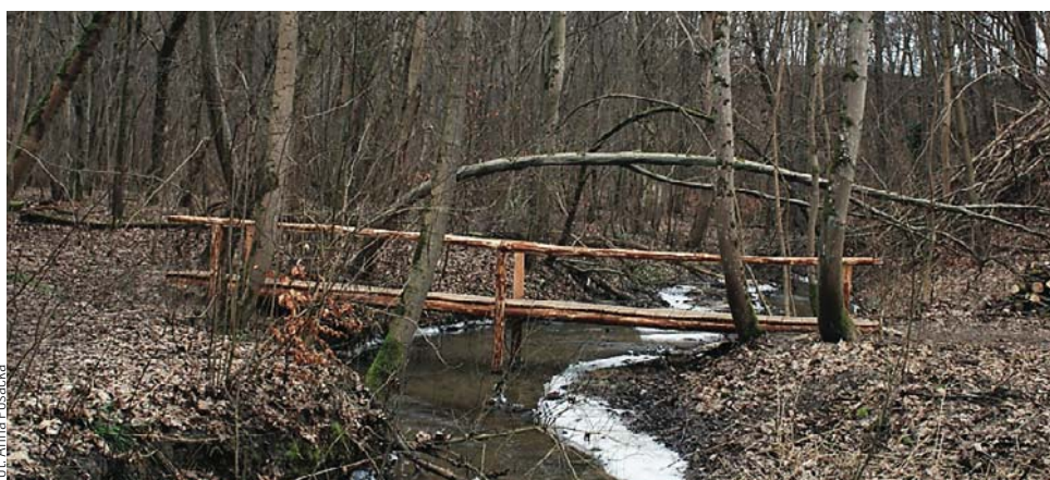
Kładka powstała w Bażantarni jest kładką techniczną. Aby wybudować nowy mostek Elewów, trzeba spełnić odpowiednie wymagania i normy
