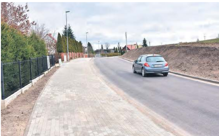
Na całej długości ulicy Mickiewicza jest nowy asfalt. Powstały też szerokie chodniki.
