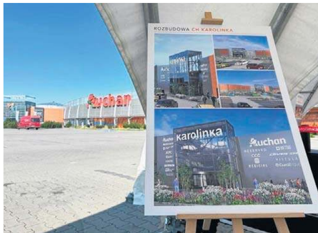
Prace przy przebudowie centrum handlowego już się rozpoczęły. Zakończą się za około półtora roku.
