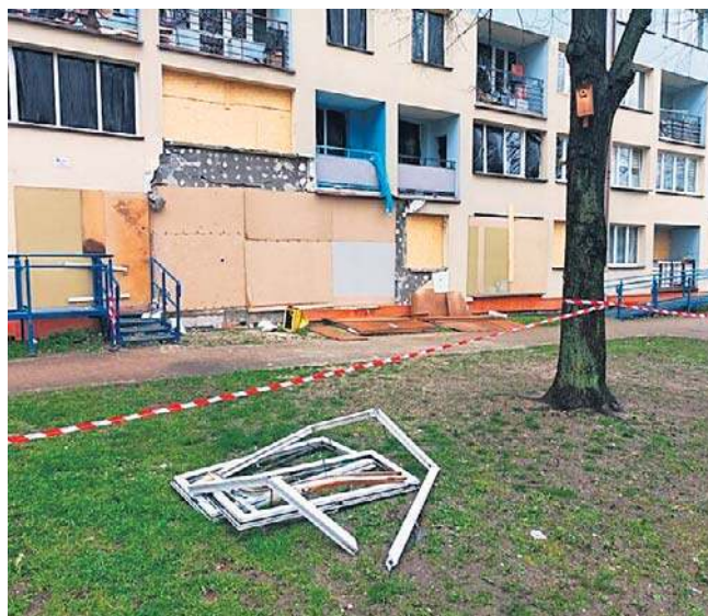
Między parterem a I piętrem trzeba odbudować strop
