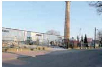
W tej hali, wybudowanej na terenie dawnej mleczarni, działalność rozpocznie wkrótce duńska firma z branży opakowaniowej.
