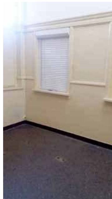
Kasa biletowa na dworcu PKP jest nieczynna od października ubiegłego roku
