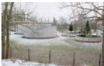
Pieniądze z dotacji można było przeznaczyć choćby na modernizację i unowocześnienie oczyszczalni ścieków - ta nowogardzka, choć wydajna oparta jest na starej technologii
