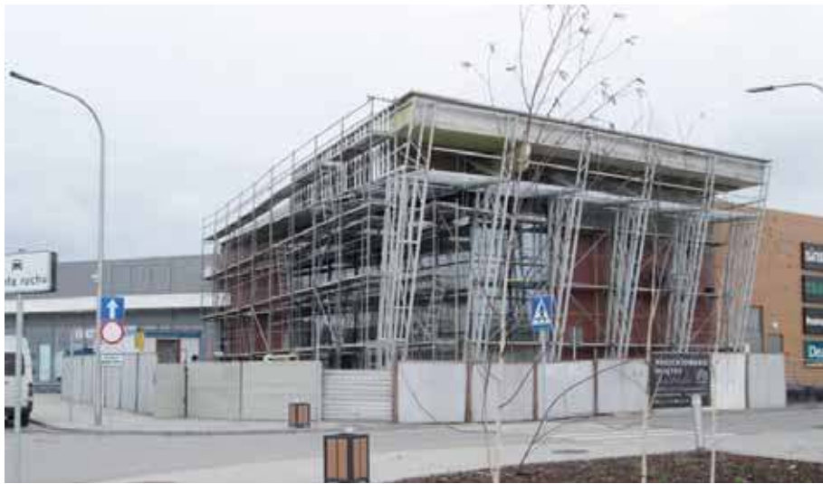
Dworzec zintegrowany w budowie
