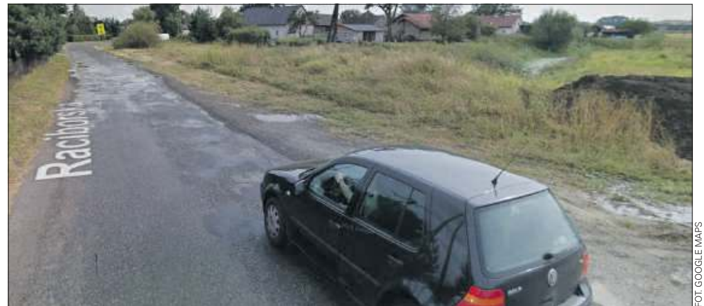
■ Modernizacji ma doczekać się kolejny fragment drogi, obejmujący 990 metrów od wału przed mostem na rzece Rudzie
