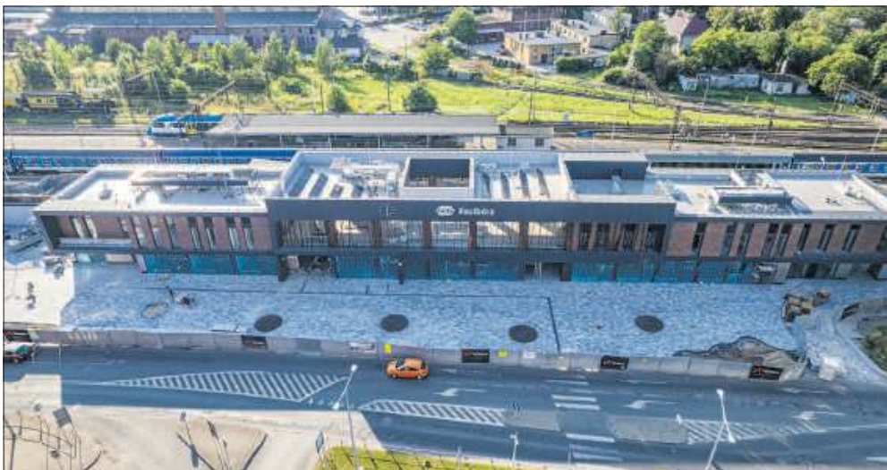
■ Widok wyremontowanego dworca z lotu drona
