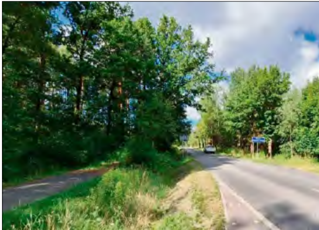
W listopadzie rozpocznie się budowa drogi dla pieszych i rowerów na odcinku łączącym miejscowość Kup z Brynicą.
