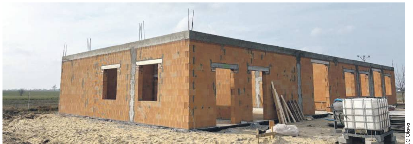
Trwa budowa świetlicy w Marszowicach
