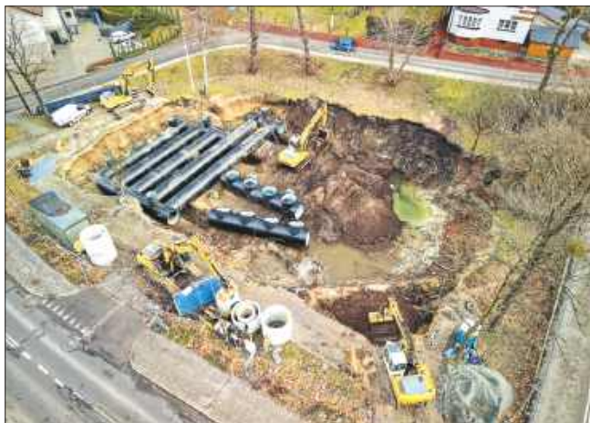
■ Budowa zbiorników retencyjnych pod parkingiem naprzeciw urzędu miasta. FOT. UM RYDUŁTOWY
