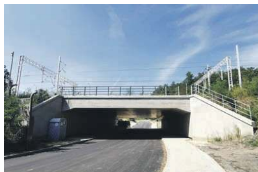
Wiadukt nad ul. Zbożową
