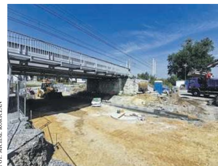
Wiadukt nad ul. 29 Listopada
