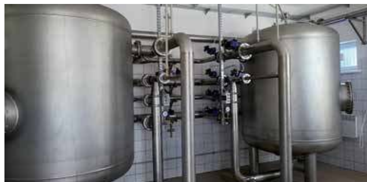
Gmina Nur - Poprawa jakości infrastruktury wodno-ściekowej na terenie gminy Nur
