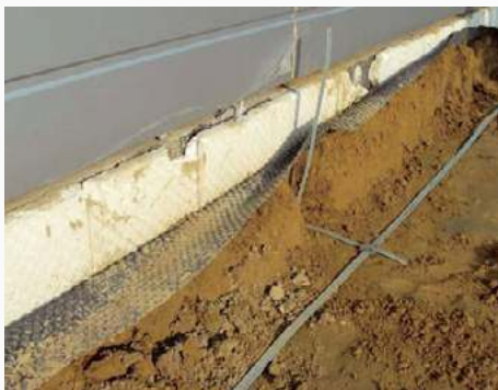
❶ Uziom to jeden z najważniejszych elementów zabezpieczających instalację elektryczną i odgromową. ARCHIWUM BD
