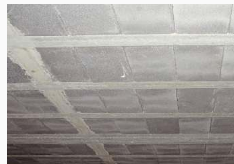
🔑 Żebra rozdzielcze w gęstożebrowym stropie teriva są niezbędne. T. RYBARCZYK
