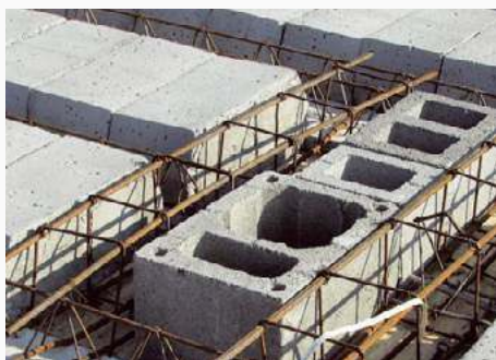
❗ Poprawne wzmocnienie stopu wokół otworu. T. RYBARCZYK
