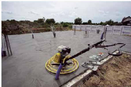
❶ Świeżo wylany beton wymaga pielęgnacji – zraszanie go przeciwdziała kruszeniu się materiału. LEGALET
