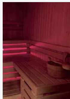
• Ściany sauny wykonano z drewna cedrowego (mocowano na wpust i pióro).
