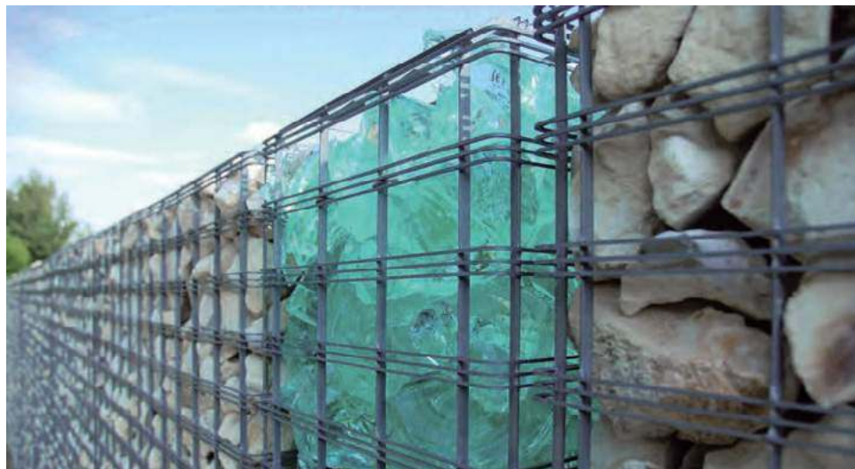
📌 Kosze różnych producentów różnią się nieco od siebie. Jako wypełnienie standardowo stosuje się kamień, choć ciekawym rozwiązaniem jest np. szkło. KONSFORT, PROGRESS ARCHITEKTURA
