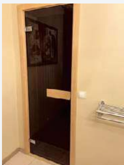
• Drzwi wykonano z hartowanego, przyciemnionego szkła o grubości 8 mm.
