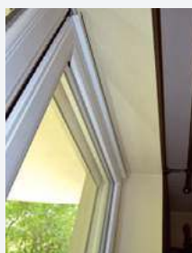
🔌 Skrzynki są ocieplone i zakryte tynkiem.
