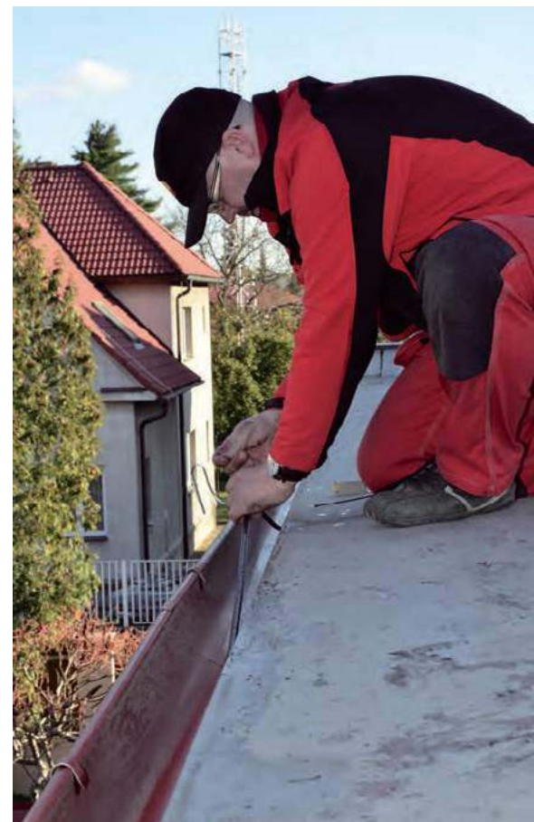
🔧 Montaż systemu przeciwołodziowego nie jest zbyt skomplikowany, ale jego podłączeniem do instalacji elektrycznej powinien się zająć uprawniony specjalista. RAYCHEM
