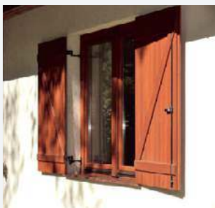
Okucia przytwierdzono do ram okien (na skrzydle widoczne zamykanie drążkowe).
