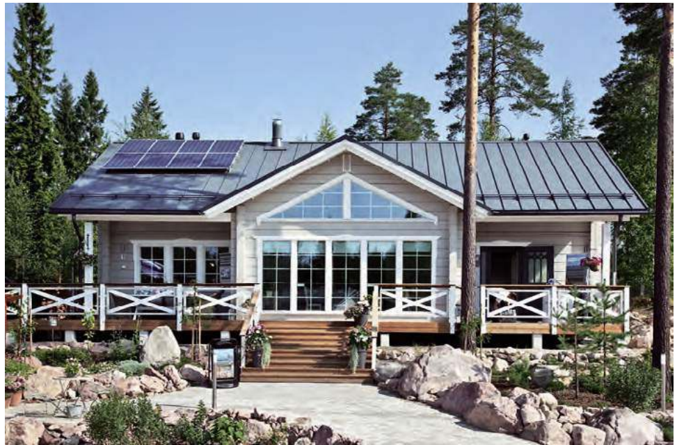
🌱 Panele PV to coraz popularniejsze rozwiązanie. W budynku o niewielkim zapotrzebowaniu na ciepło mogą wystarczyć, żeby w skali roku zaspokoić zapotrzebowanie na energię. RUUKKI
