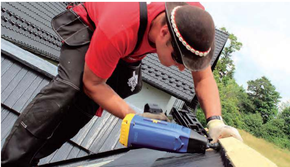
📌 Równie ważny jak wybór odpowiedniego pokrycia dachowego, jest nadzór nad pracami dekarскими. To na tym etapie często dochodzi do błędów – nieszczelnego zamocowania paroizolacji, niestarannego zamocowania pokrycia czy niedokładnego wykonania obróbek blacharskich. BLACHOTRAPEZ
