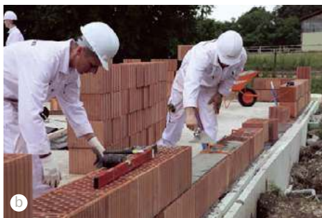
Ściany z betonu komórkowego (a SOLBET) i z ceramiki poryzowanej (b ZCB OW CZARY) najczęściej muruje się w technologii dwuwarstwowej.
