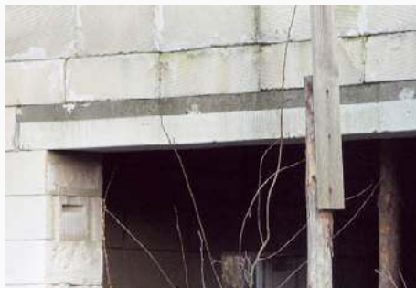
❗ Za płytkie podparcie nadproża to poważny błąd. T. RYBARCZYK
