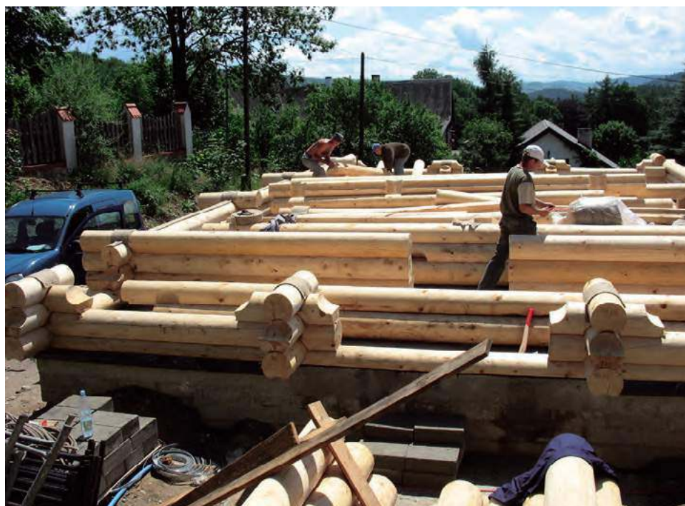
Tradycyjna ściana z bali – niestety, taka nie spełnia obowiązujących dziś wymogów dotyczących ciepłochronności przegród zewnętrznych. ARCHIWUM BD
