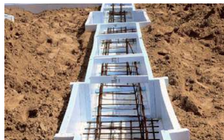
❶ Szalunek tracony XPS pozwala skrócić czas budowy fundamentów i ograniczyć rachunki za ogrzewanie domu. PRAKTECH
