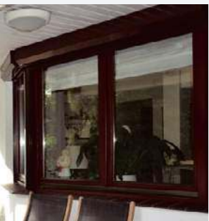
➤ Rolety elewacyjne przymocowano do ram okien.
