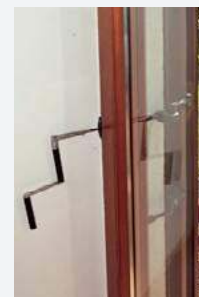
Przy oknie tarasowym zamontowano okiennice łamane, otwierane w salonie przy pomocy korbki.
