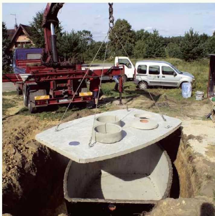
Tradycyjne betonowe szambo można założyć na większości działek. Jest trwałe i nie grozi mu wypchnięcie przez wody gruntowe. PROBUD
