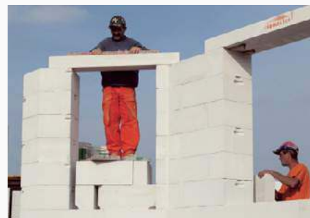
Decydując się na konkretną technologię murowania ścian należy stosować również oferowane przez ich producenta nadproża. BRUK-BET (TERMALICA)
