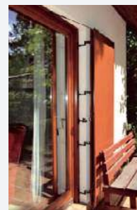
Przy oknie tarasowym zamontowano okiennice łamane, otwierane w salonie przy pomocy korbki.
