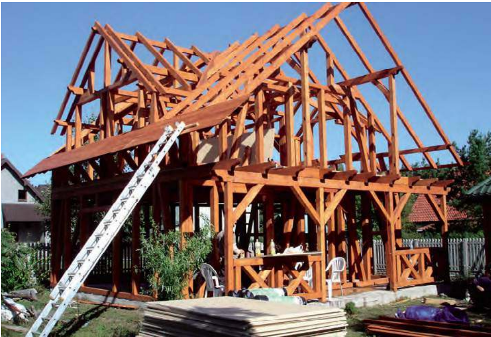
📍 Gotowa konstrukcja drewnianego domu szkieletowego. ARCHIWUM BD
