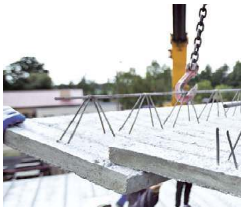
🔑 Układanie elementów stropu z płyt strunobetonowych wymaga użycia dźwigu. KONBET
