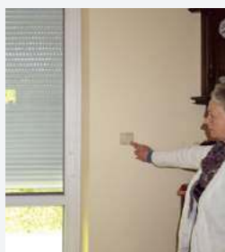
🔌 Sterowanie elektryczne założono tylko przy oknie tarasowym.
