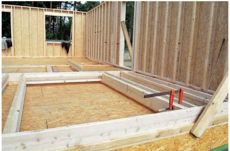
📍 W najprostszym wariantcie ściany szkieletowe montuje się na podłodze lub płycie fundamentowej, stawia do pionu, a potem objęta płytami drewnopochodnymi. KRONOPOL
