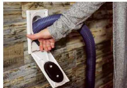
➦ Wąż do odkurzania centralnego jest przechowywany w rurociągu wewnątrz ściany. Do sprzątania wyciągamy wąż, a następnie blokujemy go za pomocą obrotowej dźwigni aby się nie cofał. TOPVAC
