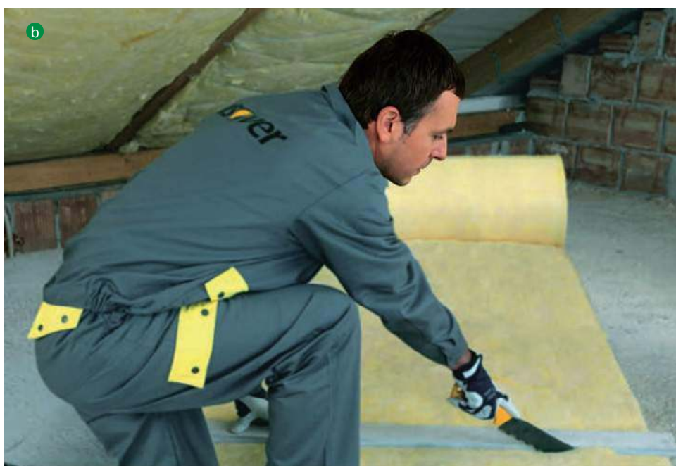
a Najpopularniejsze materiały ociepleniowe to styropian ( a STYROPIMIN) i wełna mineralna ( b ISOVER). Oba charakteryzują się podobnymi, bardzo dobrymi właściwościami termoizolacyjnymi.
