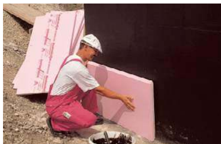
❶ Ściany fundamentowe wymagają ocieplenia. Używa się do tego polistyrenu ekstrudowanego albo specjalnej odmiany styropianu. AUSTROTHERM
