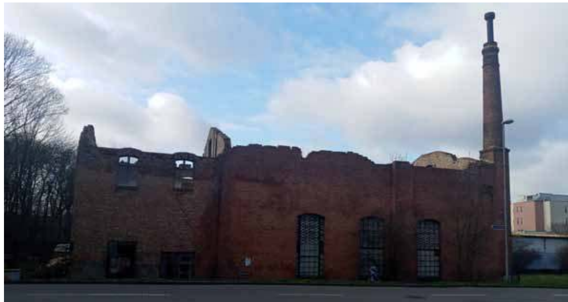
Obiekt przy ulicy Skarbowej niegdyś pełnił rolę transformatorowni
