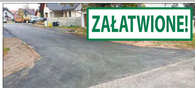
Odnoga Sosnowej jest już wyasfaltowana.
