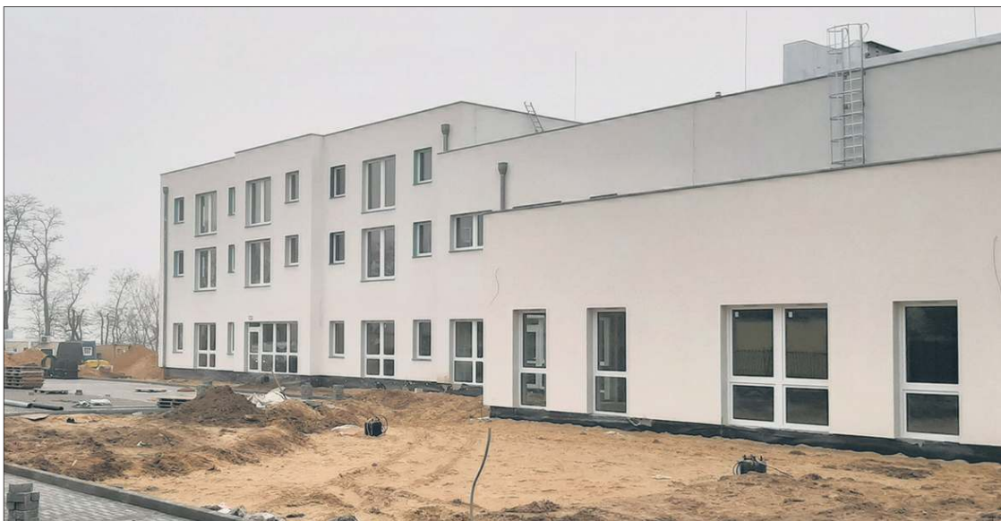
Dobiega końca budowa żłobka i bloku mieszkalnego przy ul. Kazimierza Wielkiego 52
