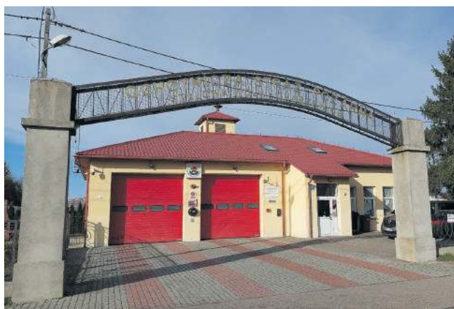
Planowana inwestycja zakłada dobudowę dwóch dodatkowych garaży oraz nadbudowę budynku, w której znajdzie się nowoczesna świetlica o powierzchni blisko 300 metrów kwadratowych
