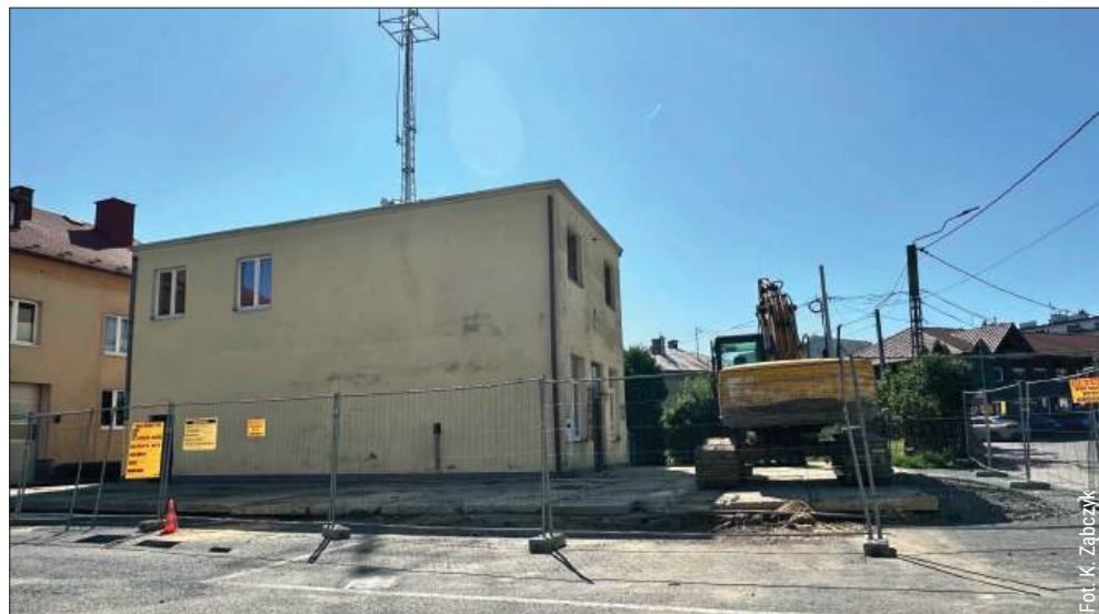
Tak obiekt wyglądał przed zburzeniem.
