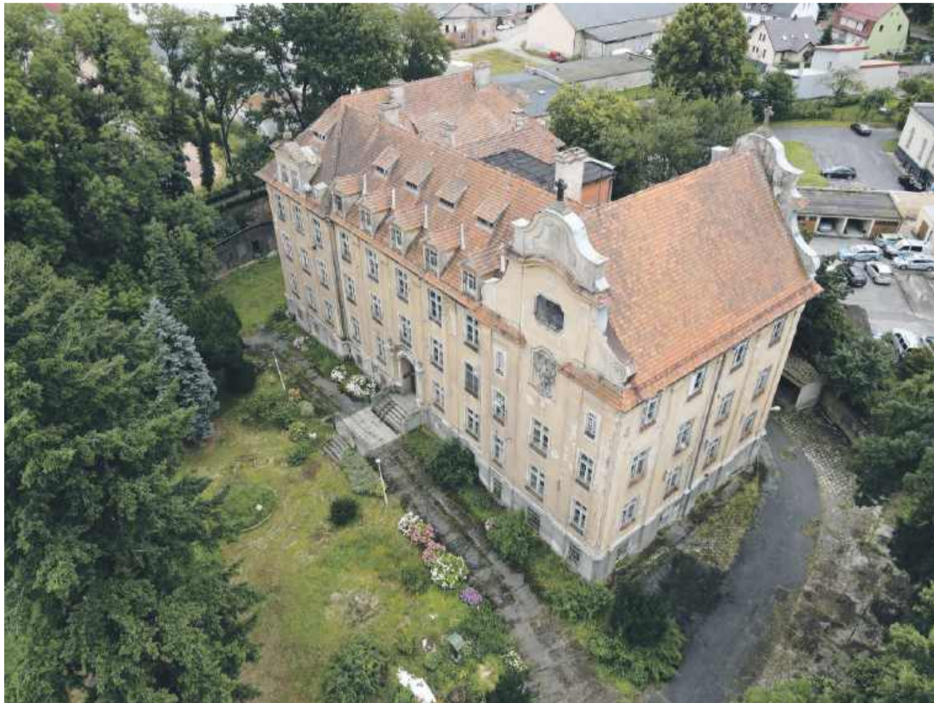
Gmina w 2021 roku, korzystając z prawa pierwokupu, za blisko 8 mln zł kupiła od siostr Boromeuszek stary budynek. Od 4 lat stoi i niszczeje. Został nawet splądrowany
