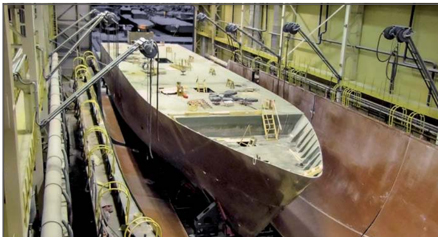
Usuwanie matrycy z formowanego kadłuba trałowca bazowego projektu 12700.
