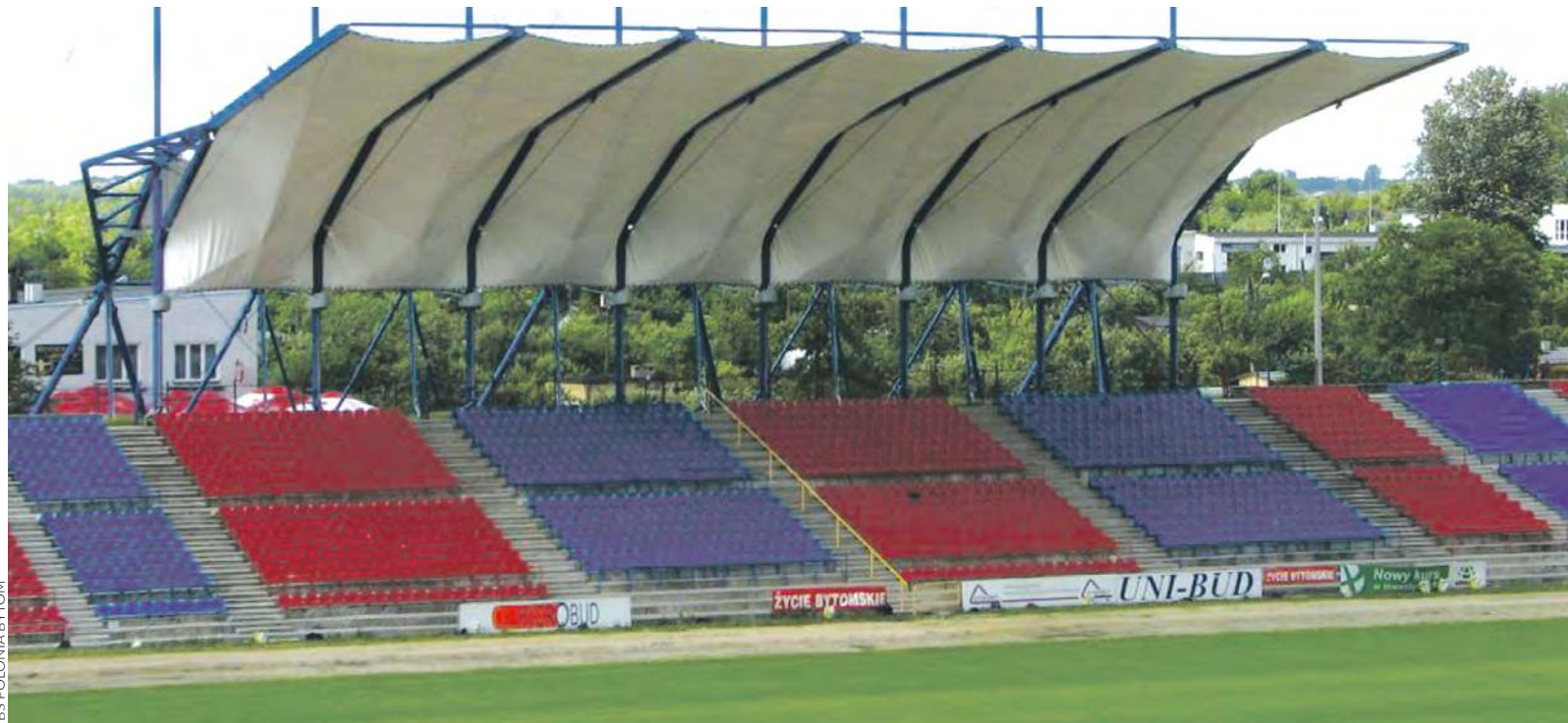
Rozbiórka, a w zasadzie dewastacja starego stadionu bytomskiej Polonii rozpoczęła się w roku 2016
