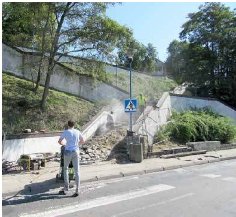
Demontują schody po lewej stronie
