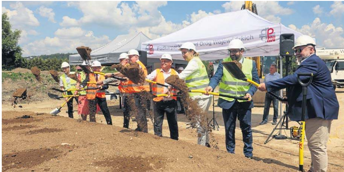
To symboliczne wbicie łopaty przez notabli oficjalnie rozpoczęło budowę obwodnicy Tyczyna
