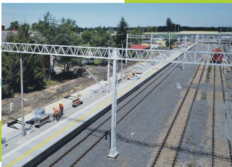
Prace na stacji kolejowej Tarnobrzeg
