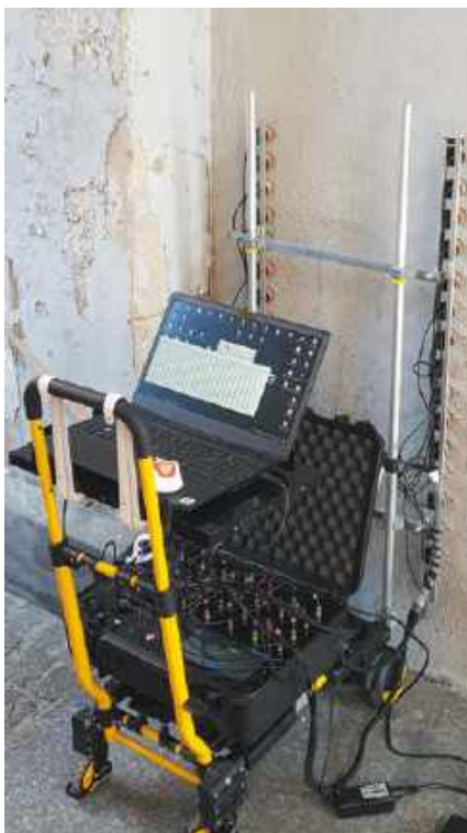
FOT. 2 Badania in situ wilgotności muru ceglanego zaawansowaną wersją tomografu impedancyjnego w budynku Złotej Bramy w Gdańsku; fot.: AH
