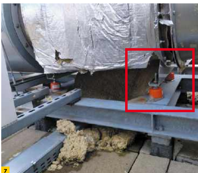
FOT. 7-8 Wibroizolacja wentylatorów bytowych garażu – niepoprawna (8) poprawna (9); fot.: Falcon Acoustics
