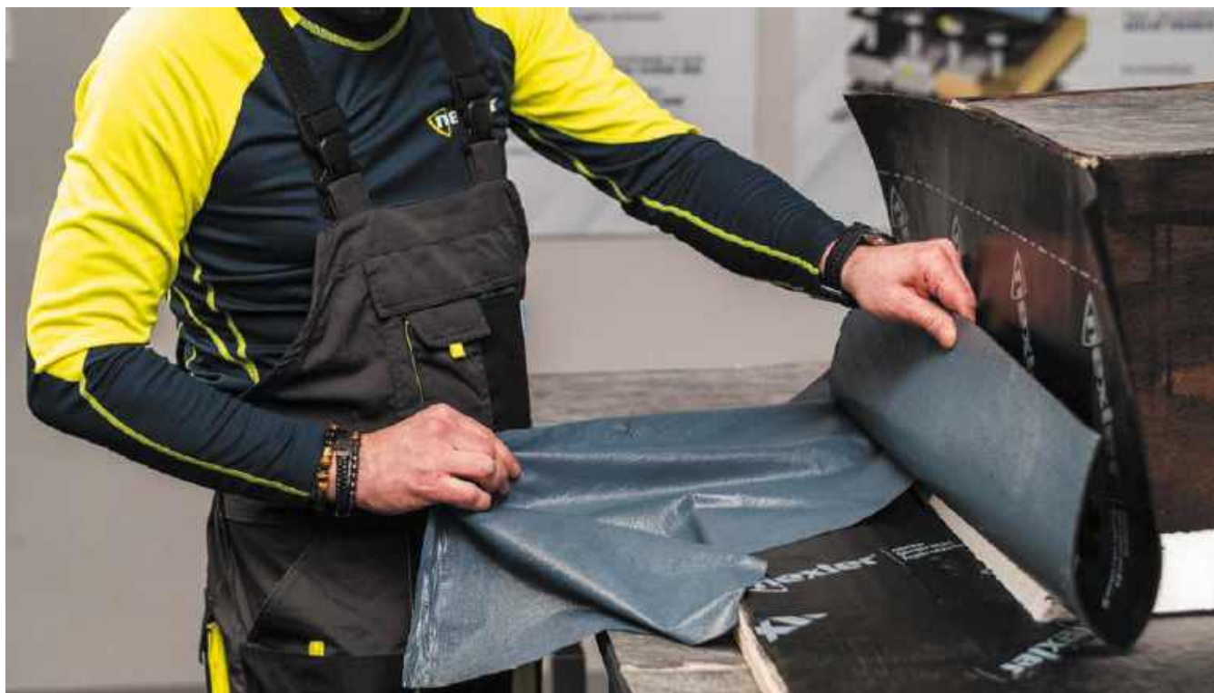
FOT. 3 Aplikacja papy samoprzylepnej na detalu – szczelność zakładu uzyskiwana bez użycia otwartego ognia; fot.: NEXLER
