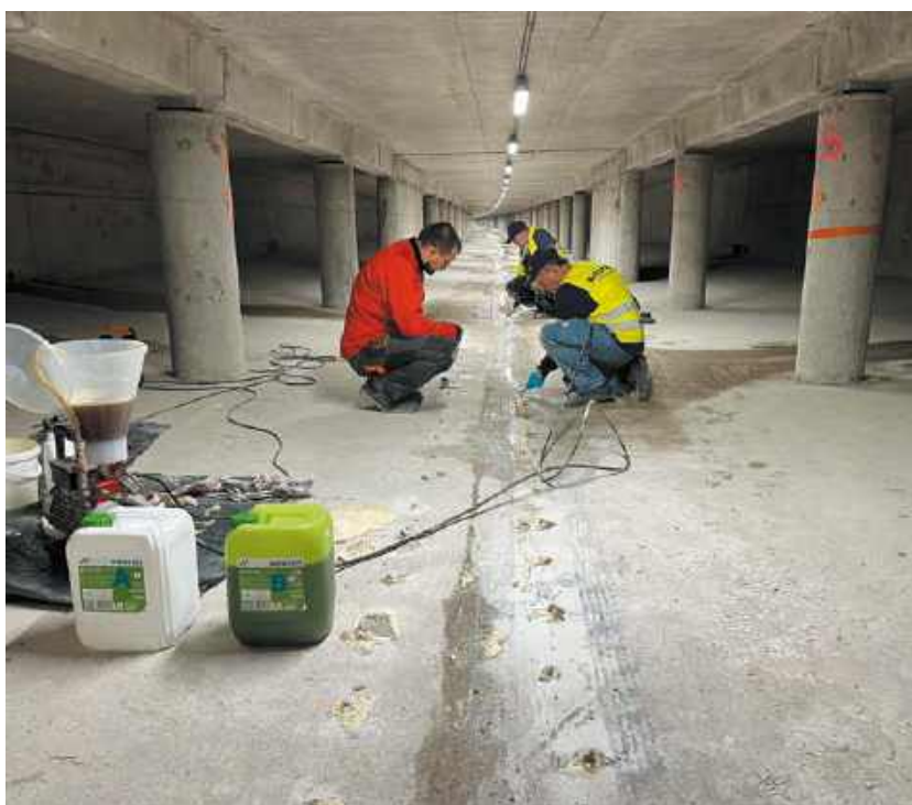
FOT. Iniekcja uszczelniająca przerwy roboczej, żywica hybrydowa KÖSTER 2 IN 1
