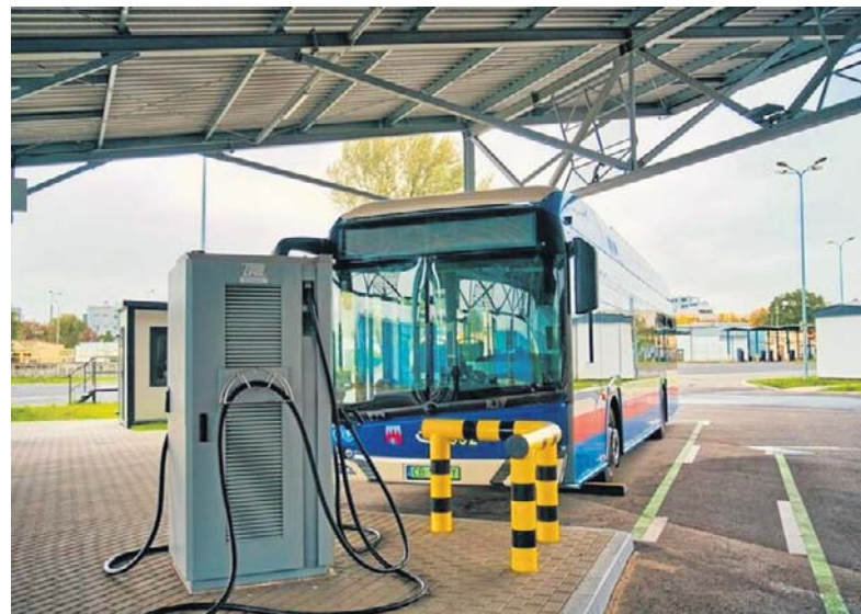
W maju MZK zakupiły 11 elektrobusów. Teraz spółka zakończyła budowę elektrowni fotowoltaicznej i infrastruktury do ich ładowania
