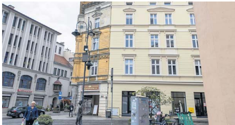
Rozpoczął się drugi etap renowacji zabytkowej kamienicy u zbiegu ulic Dworcowej i Pomorskiej.
