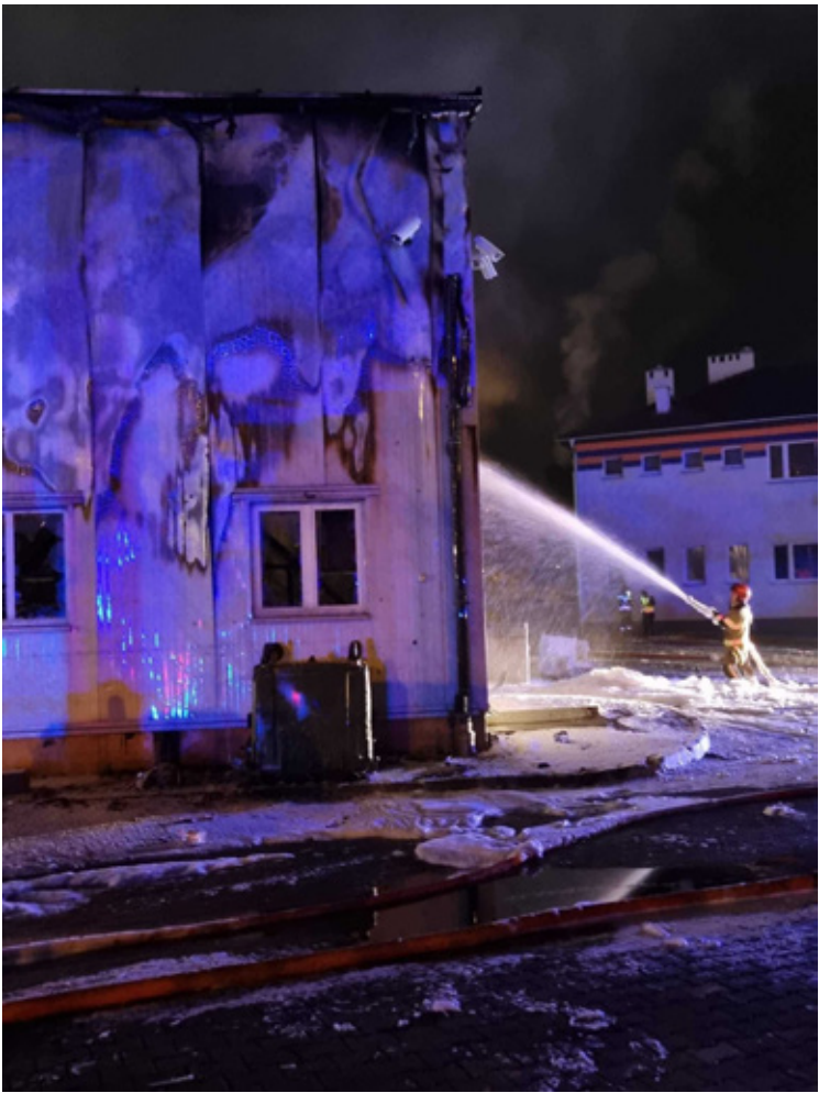
Fot. KPP Straży Pożarnej w Wołowie
