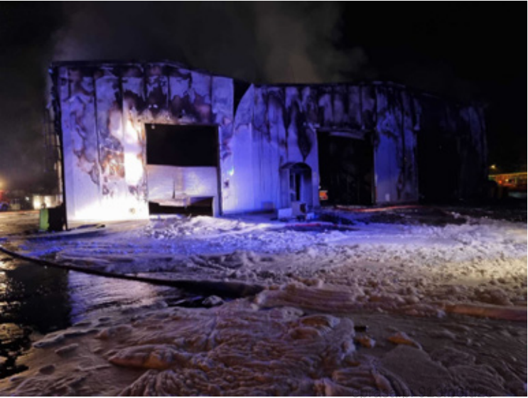
Fot. KPP Straży Pożarnej w Wołowie
