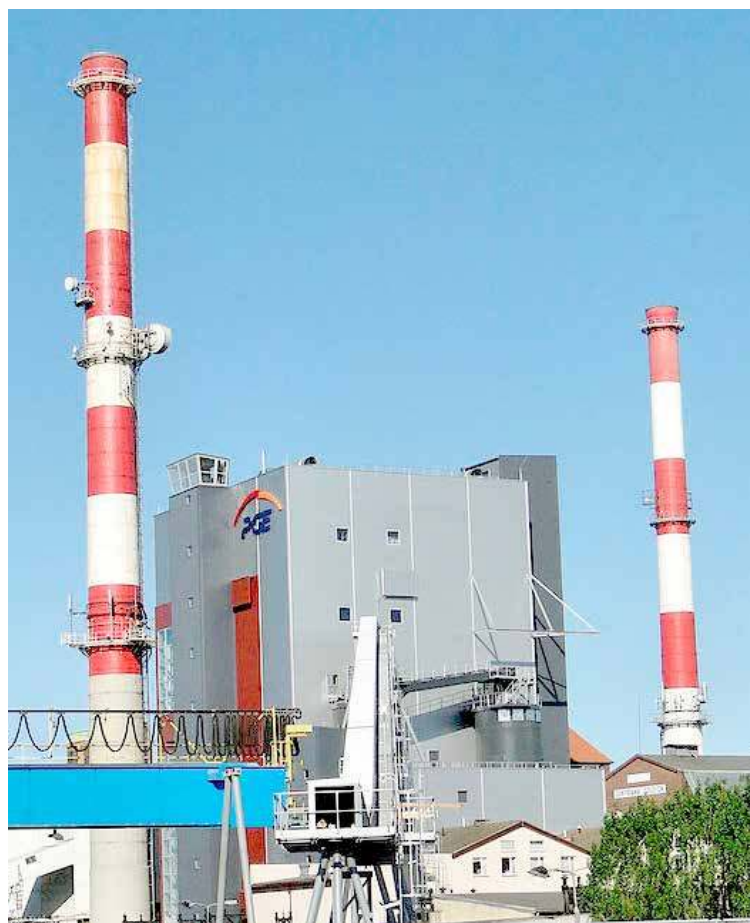
Elektrownia Szczecin kocioł na biomasę
