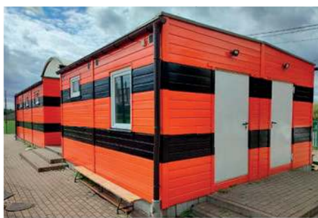
Modernizacja "Orlików" w Kraszewie i Ojrzeń - 255 163 zł
