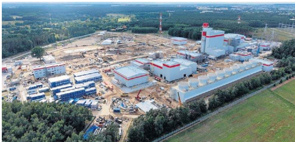
Teren inwestycji CCGT Grudziądz. Praktycznie taka sama elektrownia gazowo-parowa powstaje w Gdańsku, obok Rafinerii Gdańskiej
