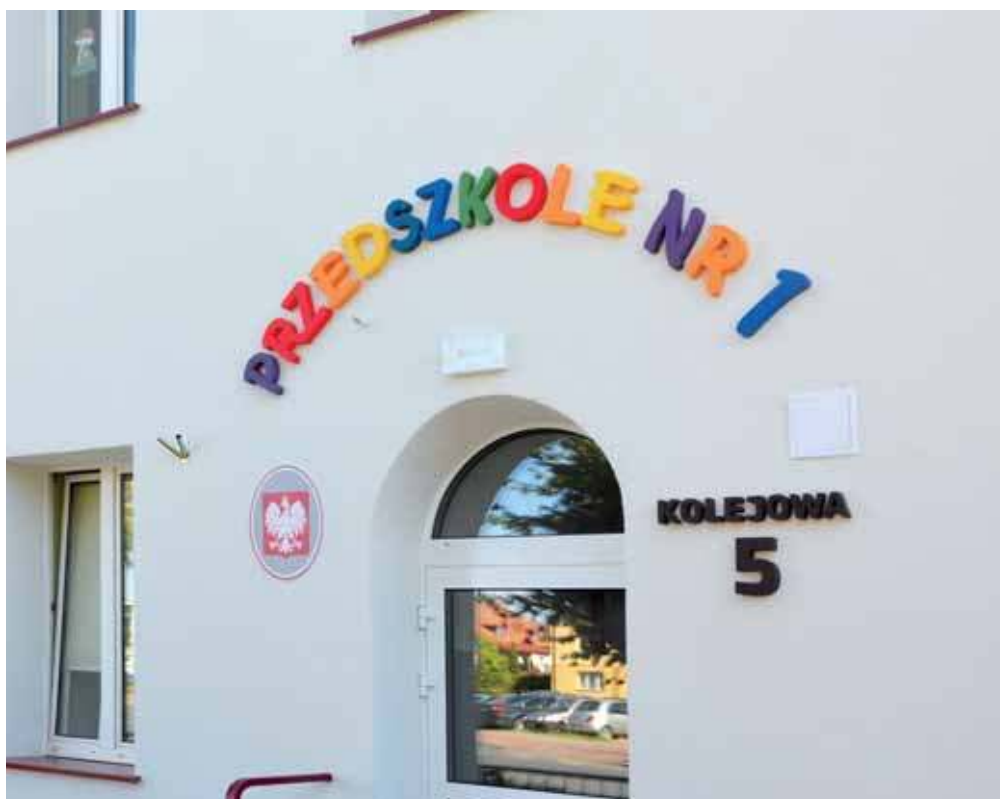
...i po modernizacji
