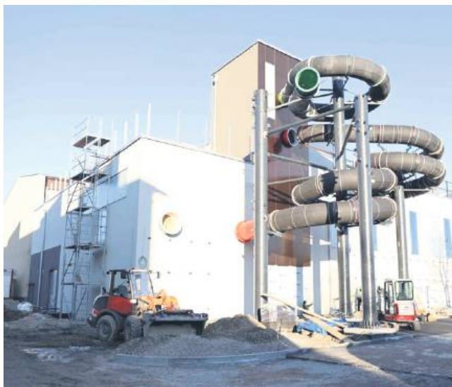
Po blisko 40 latach basen doczekał się remontu.
