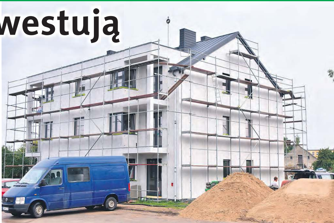
Aktualny, zaawansowany etap prac w Kęsowie. Wykonawca nie wyraził zgody na wykonanie zdjęć wewnątrz.
