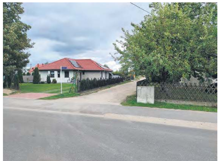
Wjazd w nową ulicę Siewną w Bysławku od strony drogi powiatowej.
