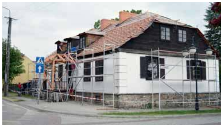
Prace przy przebudowie muzeum w Bieżuniu
