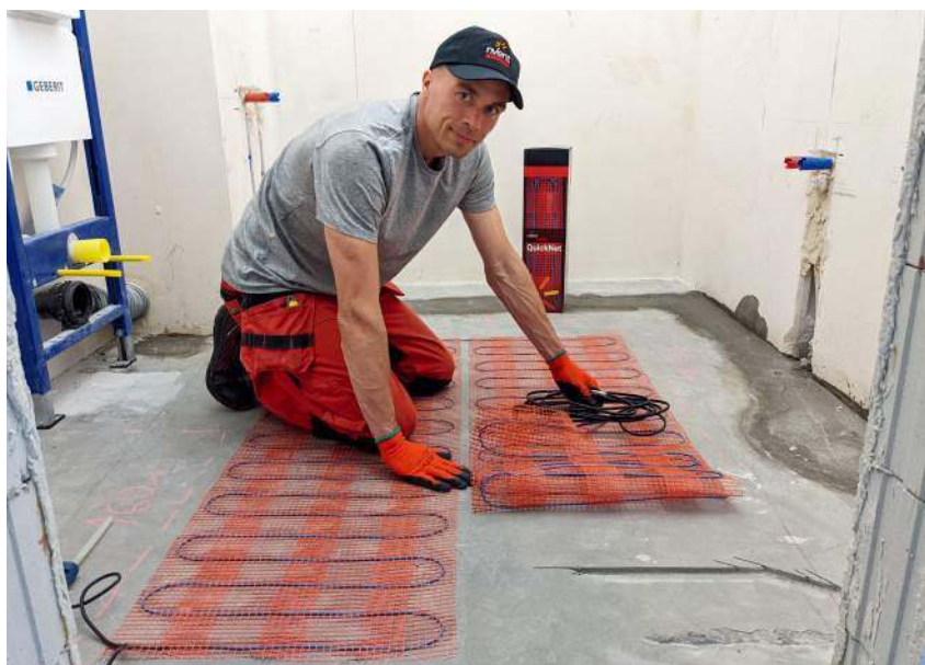
❷ Układanie maty grzewczej. NVENT RAYCHEM
