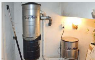
➊ Jednostkę centralną typu split zamontowano w pomieszczeniu pod schodami.
