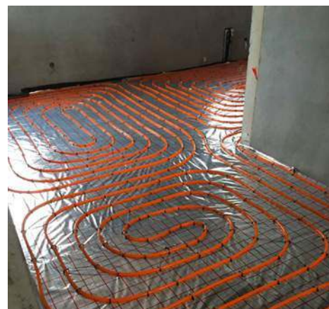
🔦 Pompy ciepła mogą pracować w instalacjach z grzejnikami (a ARCHIWUM BD), ale lepiej sprawdzą się we współpracy z niskotemperaturową wodną podłógówką (b RWC).
