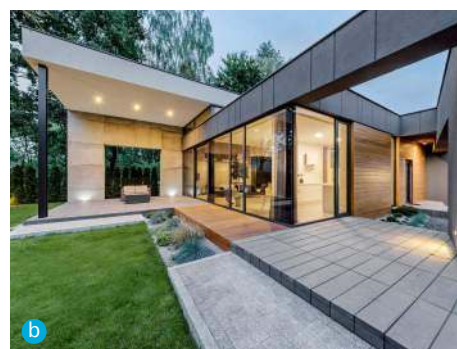
❶ Szklane fasady, ogrody zimowe (a VEKA) oraz przeszklenia kątowe obejmujące narożniki bez pionowego słupka (b G-U POLSKA/BECZAK & BECZAK) wykonuje się z profili aluminiowych.
