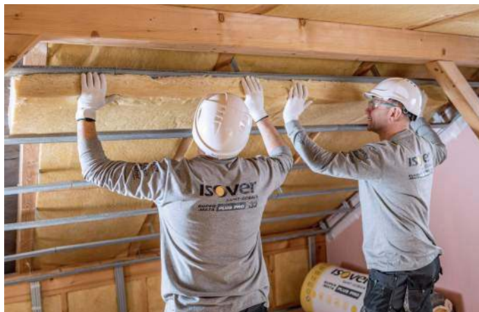
🔦 Wełna mineralna to najpopularniejszy materiał do ocieplania dachów skośnych. ISOVER
