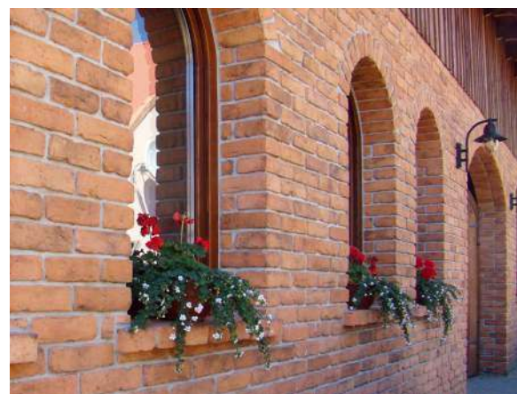
🔧 Płytki cementowe mocuje się do ścian za pomocą kleju, szczeliny wypełnia fugą i zabezpiecza impregnatem (po 24 h). ELKAMINO DOM
