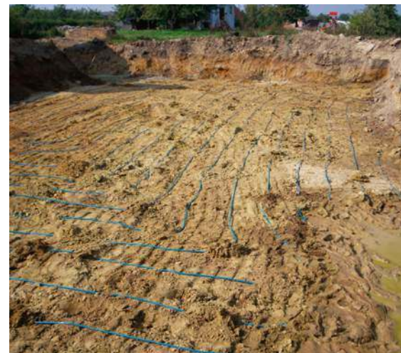
📍 Wykop pod poziomy kolektor gruntowy. CLIMA KOMFORT
