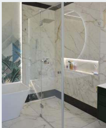
➋ Natrysk oddzielono szklanymi ściankami (z drzwiami).
