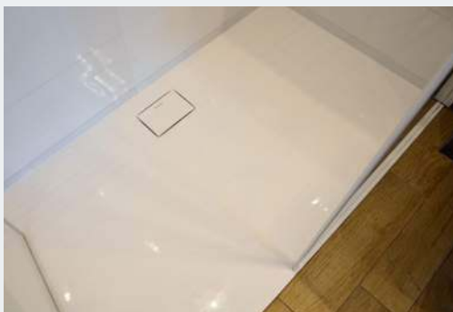
● Brodzik, przeznaczony do wpuszczenia w podłogę, zlicowano z nawierzchnią z płyt gresu.
