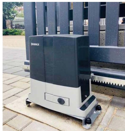
➤ Napęd bramy przesuwnej samonośnej, widoczna listwa zębata na skrzydle. BENINCA
