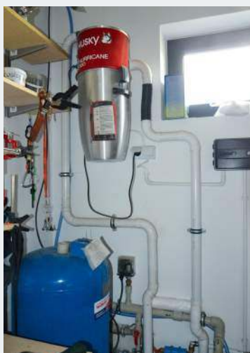
➊ Jednostka centralna z podwójną filtracją zanieczyszczeń jest wykonana z nowoczesnych trwałych materiałów.
