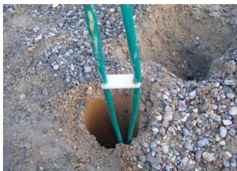
🔦 Sonda w odwiercie pionowego kolektora gruntowego. SOFATH
