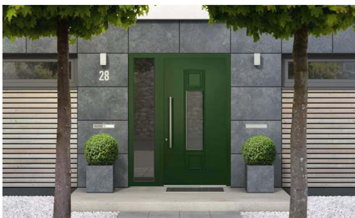
📌 Przepisy dotyczące drzwi wejściowych nie są zbyt rozbudowane. Jedno z wymagań dotyczy ich rozmiarów. Minimalna szerokość w świetle ościeżnicy to 90 cm, a wysokość przynajmniej 200 cm. BUDVAR
