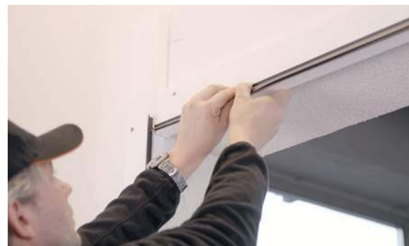
❹ Brama garażowa montowana z użyciem dodatkowych uszczelek na obwodzie i specjalnie wyprofilowanego twardego styropianu EPS. KRISPOL
