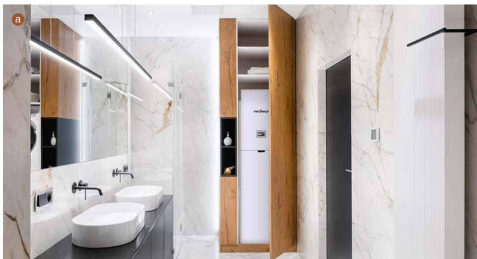
📍 Pompę ciepła można postawić w łazience (a IGLOTECH), albo garażu (b NIBE-BIAWAR). Kotłownia nie jest potrzebna.
