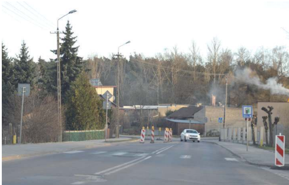
Remont fragmentu drogi krajowej będzie dużym utrudnieniem dla mieszkańców i kierowców, którzy często poruszają się tą trasą. Będą musieli oni pokonywać dodatkowe 3 km objazdów
