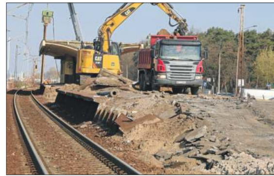
Modernizacja linii kolejowej w Otwocku
