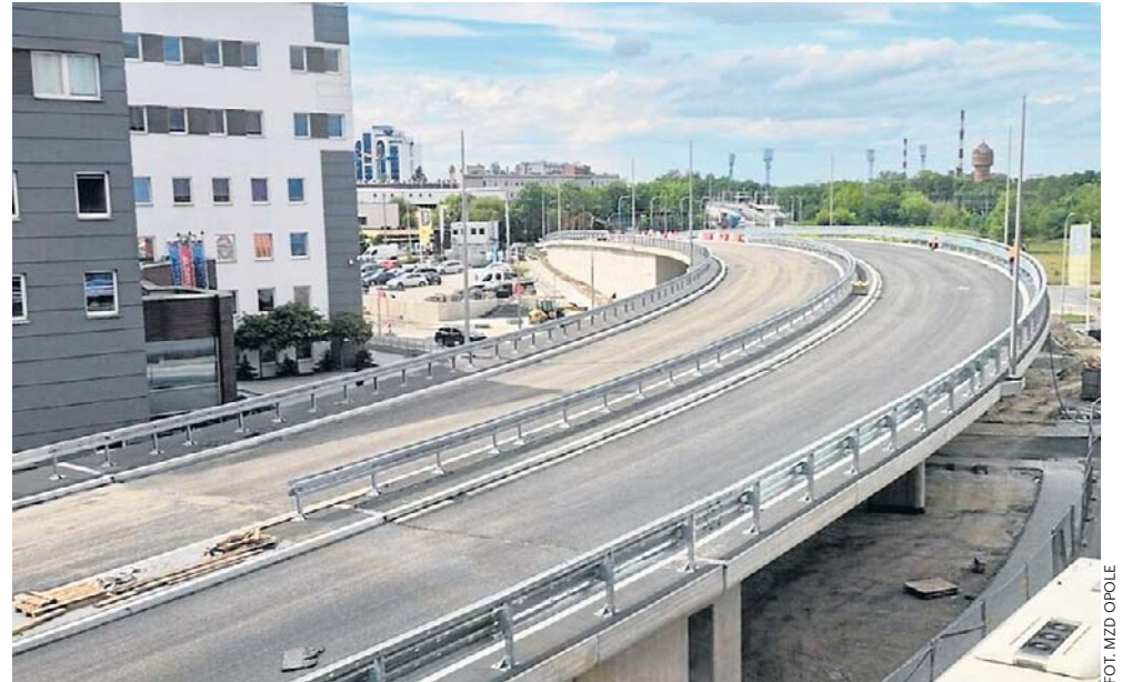
Budowa estakady w centrum Opola dobiega powoli do końca. Od środy pojedziemy pierwszym udostępnionym na niej pasem.
