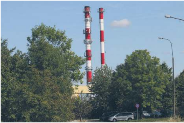
Ciepłownia będzie korzystać teraz z nowego, „cieńszego” komina
