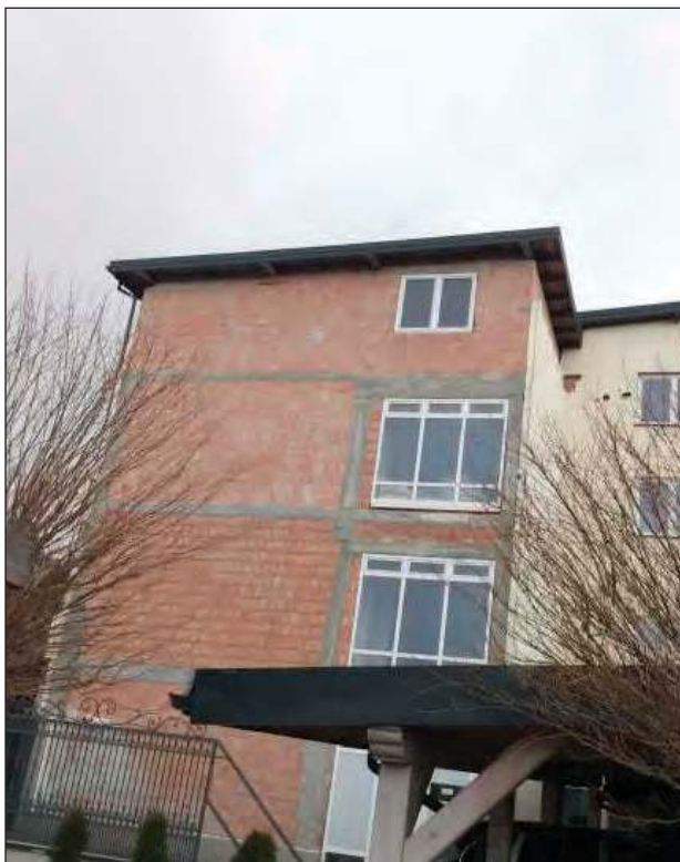
■ Klatka schodowa na samej górze, od której zaczęło się całe zamieszanie
